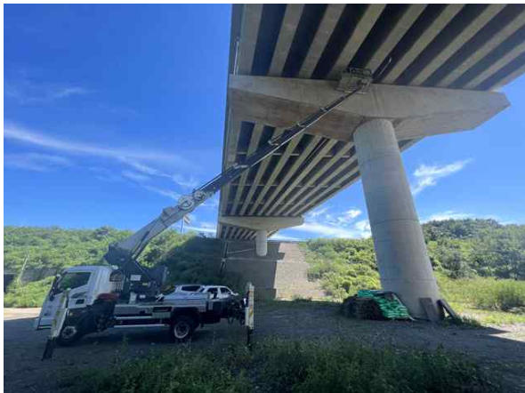
고소점검차를 이용한 근접조사
